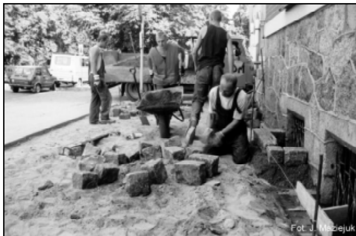
Prace wykonują pracownicy spółki „Drogi i Mosty”
