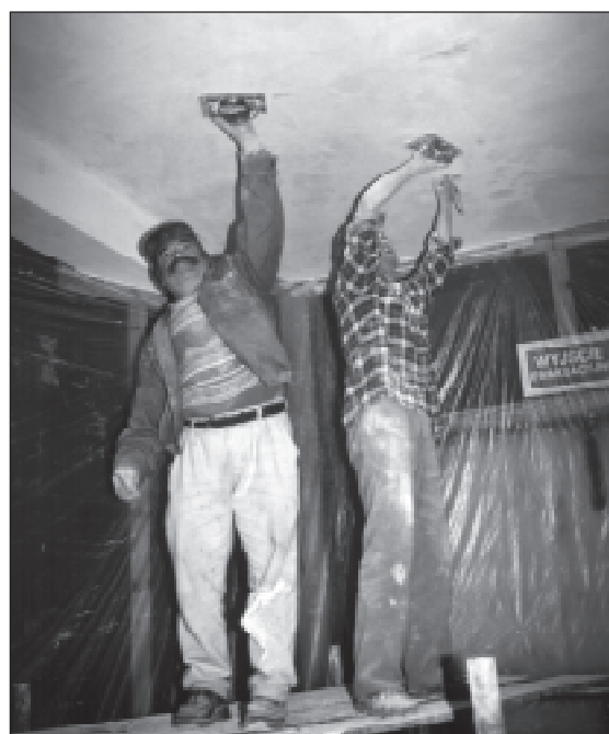
Przed malowaniem - wygładzenie tynków
