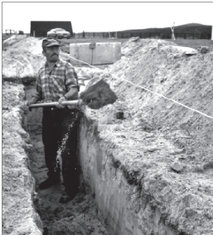
W Gardnie Wielkiej bezrobotni zatrudnieni w ramach robót publicznych wykonują na stadionie sportowym wykopy pod fundament nowej szatni
