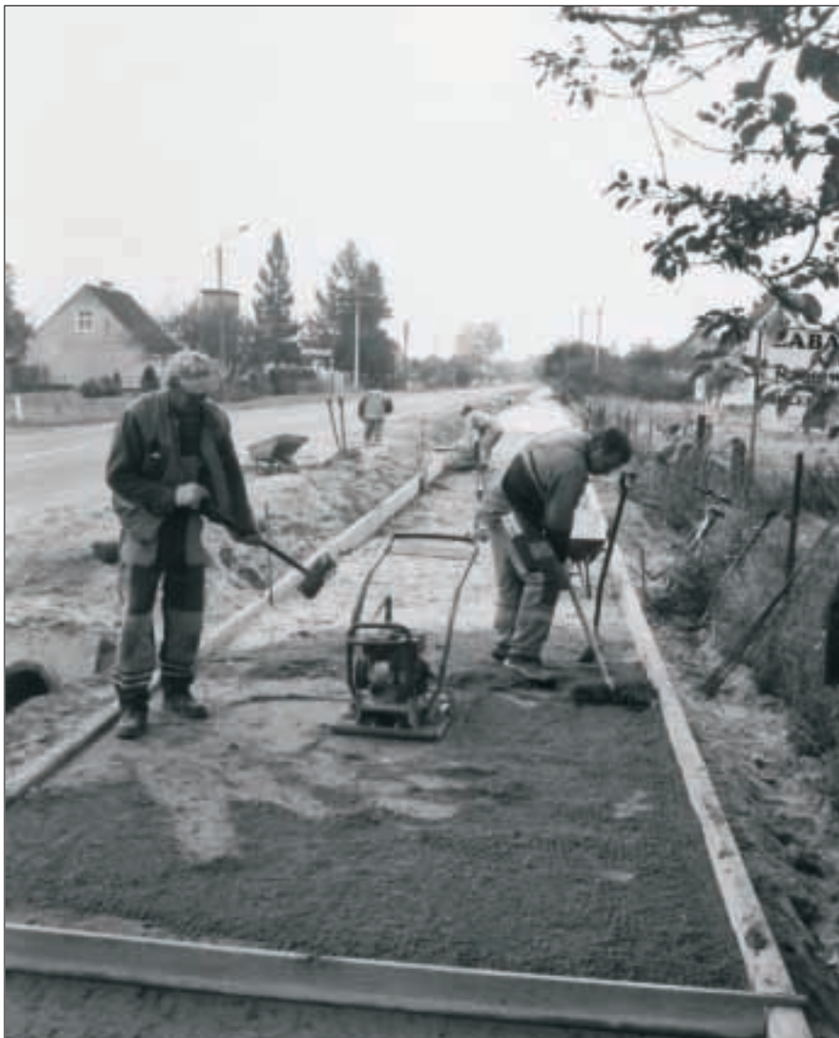
W Łosinie przy drodze krajowej Nr 21 powstaje nowy chodnik, który umożliwi dogodne przejście przy bardzo ruchliwej arterii komunikacyjnej
