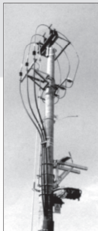
Kompletna konstrukcja pod słupową stację transformato- rową na żerdzi wirowanej
