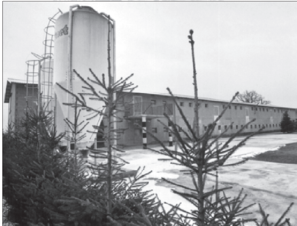
Zmodernizowany kurник w Bierkowie
