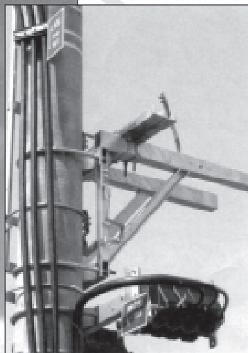
Konstrukcja pod ogranicz- niki przepięć
