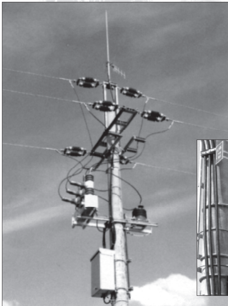
Konstrukcja pod ogranicz- niki przepięć
