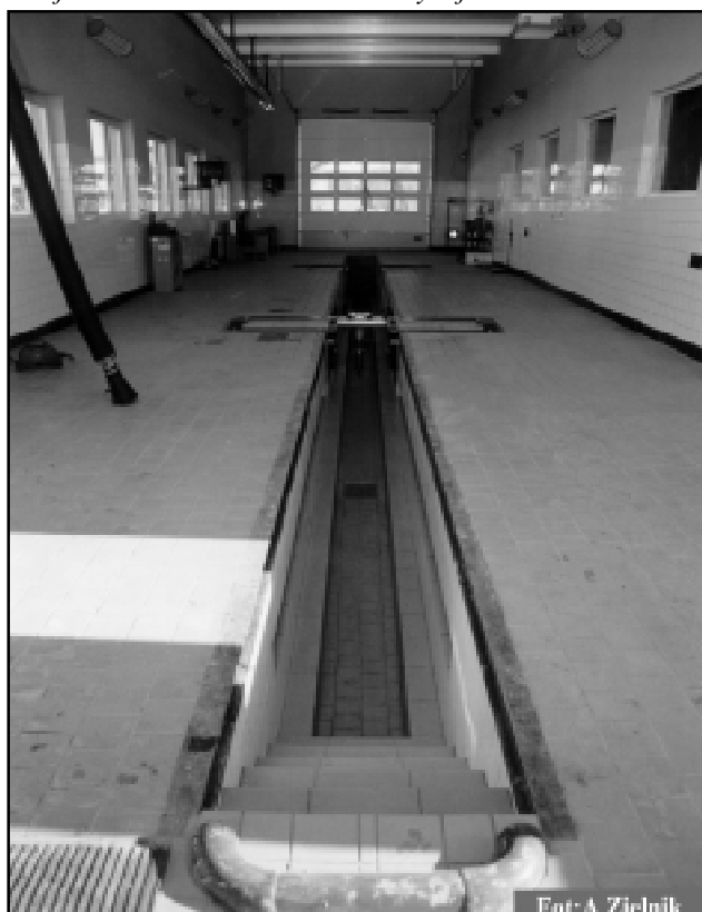
22-metrowy kanał przeglądowy w Kobylnicy
