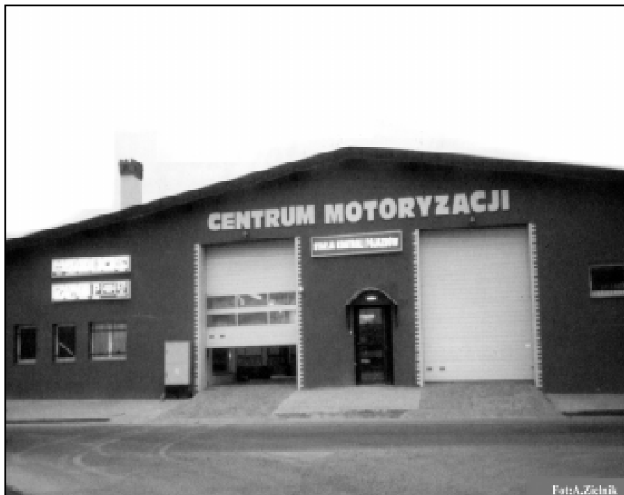
Stacja w Usteckim Centrum Motoryzacji
