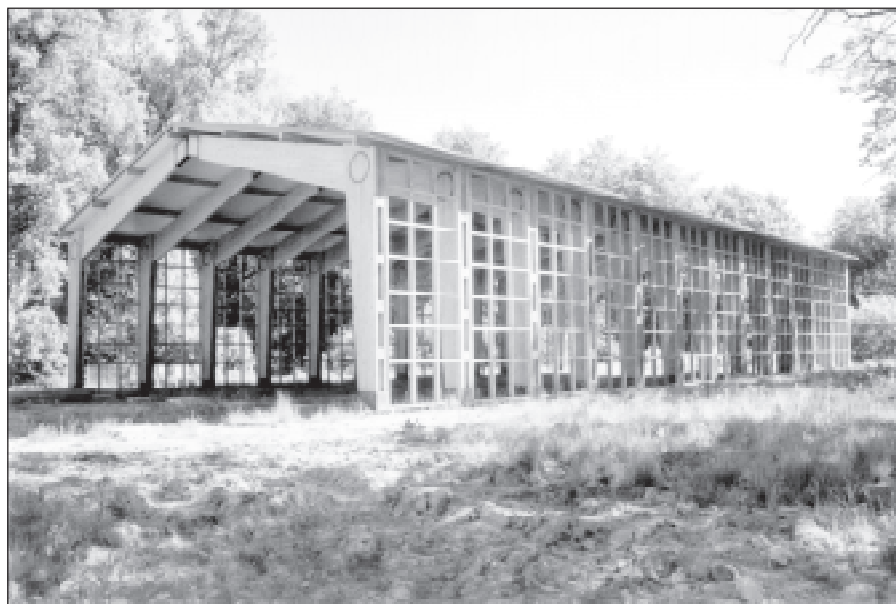
Konstrukcja nowej hali sportowej budowanej przy Szkole Podstawowej w Pobłociu
