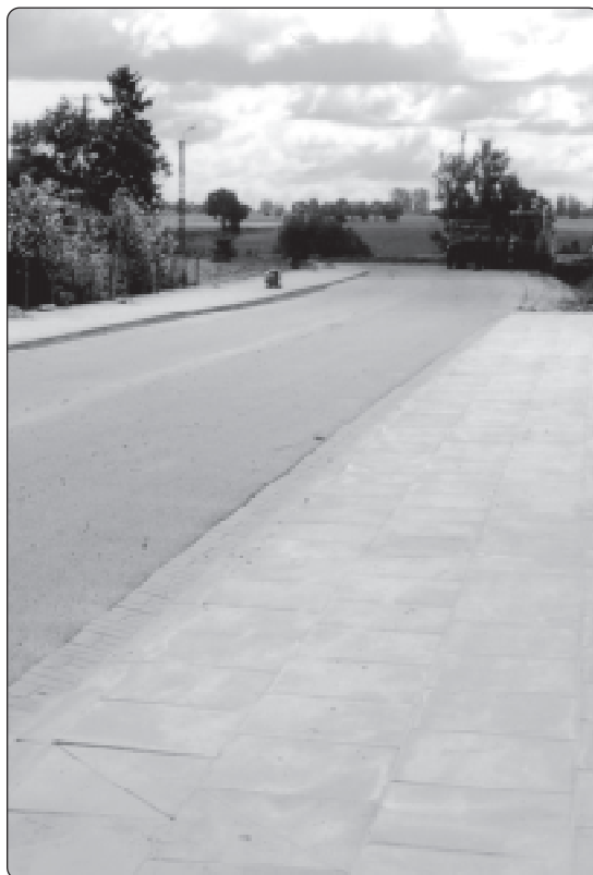
Nowa nawierzchnia drogi Bobrowniki - Stara Dąbrowa.
