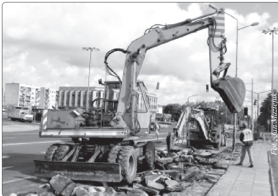
Słupsk. Budowa ronda u zbiegu ulic: Szczecińskiej, 11 listopada i Koszalińskiej.
