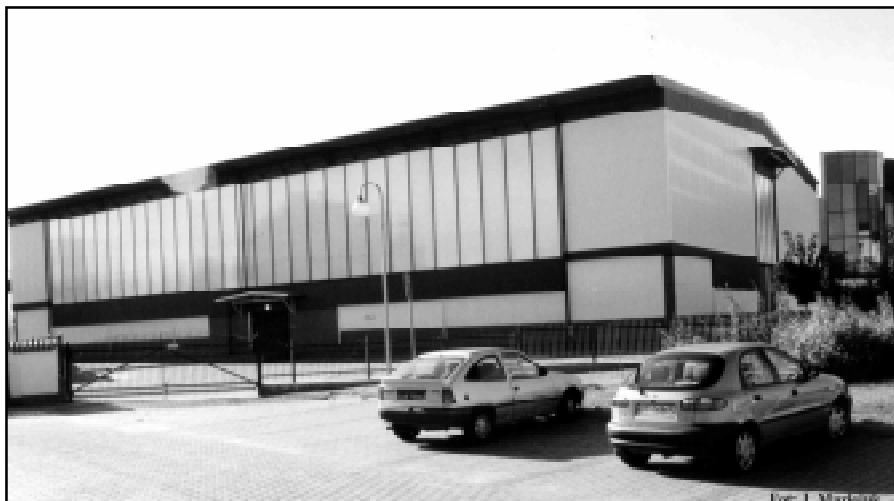
Budynek hali w całej okazałości
