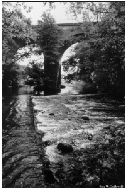
Trzyłukowy wiadukt kolejowy
