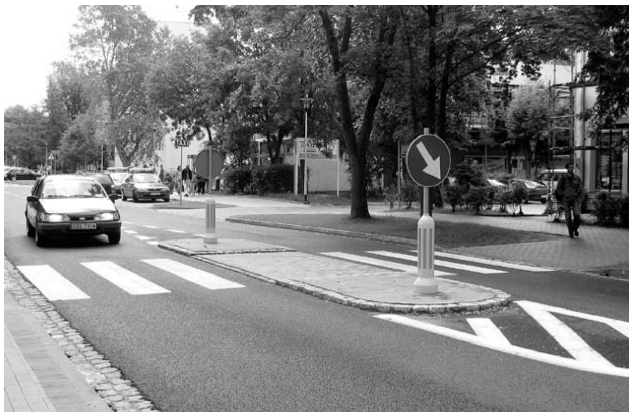
Remont ul. Grunwaldzkiej w Ustce obejmował wykonanie przejść dla pieszych z wydzielonymi wysepkami
