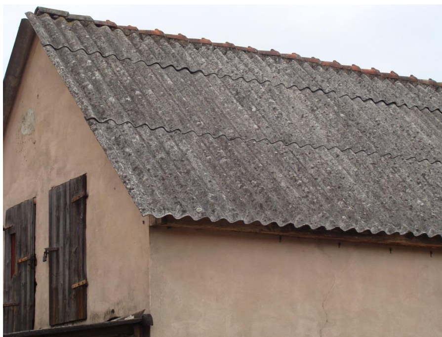
Ryc. 17. Dach budynku gospodarczego pokryty płytami cementowo - azbestowymi. Fot. Małgorzata Wojtan.
