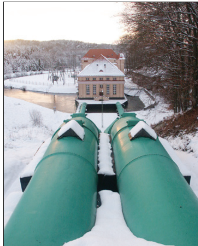
Elektrownia Wodna w Gałąźni Małej w blasku zachodzącego słońca
